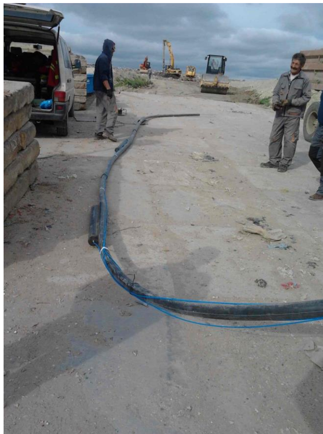
19. ábra: A mérőszonda előkészítése a helyszínen.
